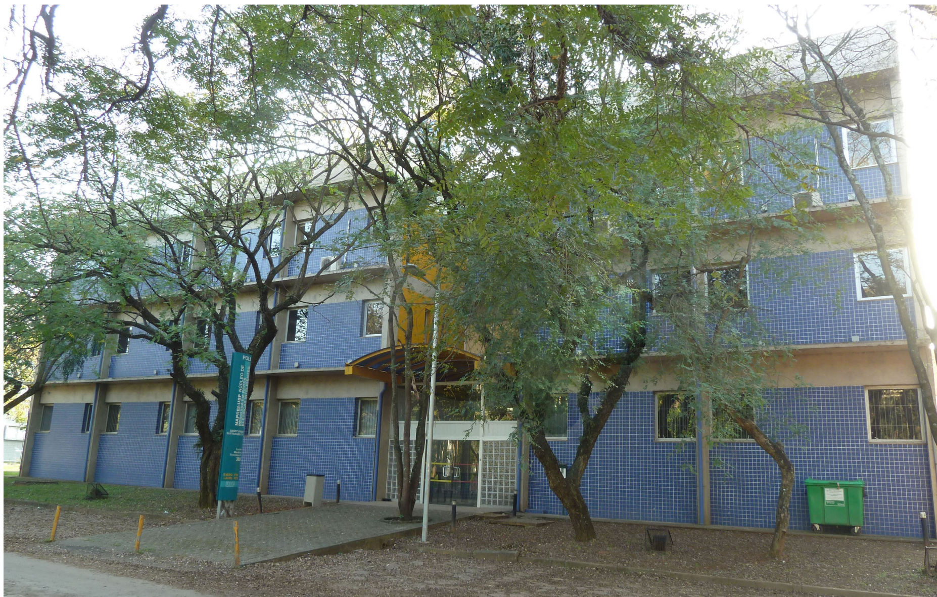
Fotografia do edifício do Enerq-CT.
