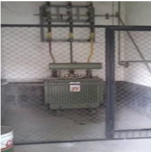
Figura 3 – Vedação em rede metálica para equipamentos com partes acessíveis normalmente em tensão
