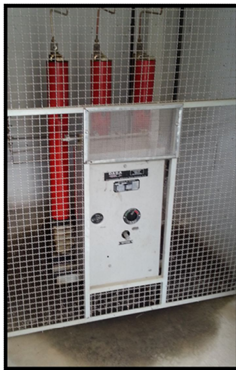
Figura 3 – Disjuntor de MT com vazamento de óleo
