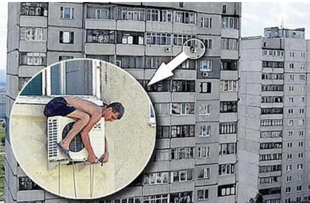
Figura 1: Instalação de unidade condensadora
