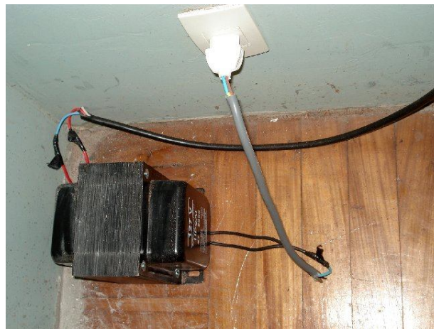
Figura 6 - Transformador para ligar aparelho 220 V em tomada 110 V, deixado sobre o assoalho.
