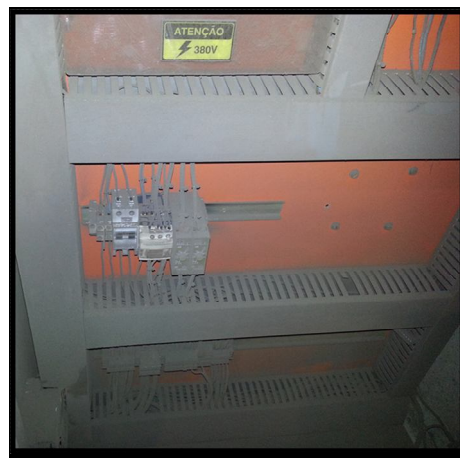
Figura 4 – Conjunto de Manobra de BT
