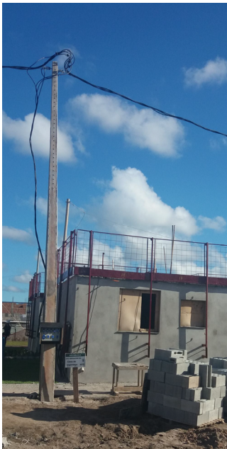
Figura 4: Vista de uma rede de distribuição aérea de um canteiro de obras visitado.
