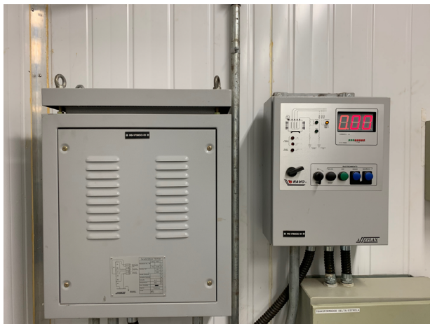
Figura 12 - Sistema de aterramento por RAVO
