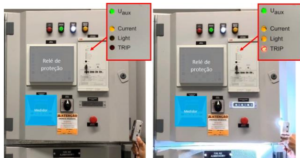
Figura 10 – Teste de atuação utilizando luz e câmera fotográfica
