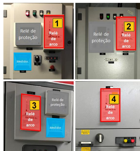
Figura 3 – Relé de arco
