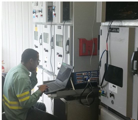
Figura 19 – Teste relé de acionamento
