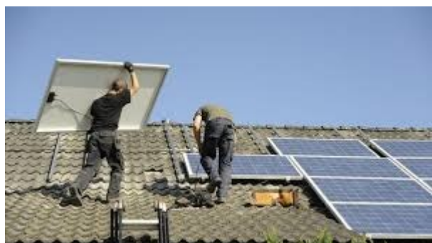
Profissionais carregando e instalando módulos Fotovoltaico – Acervo próprio
