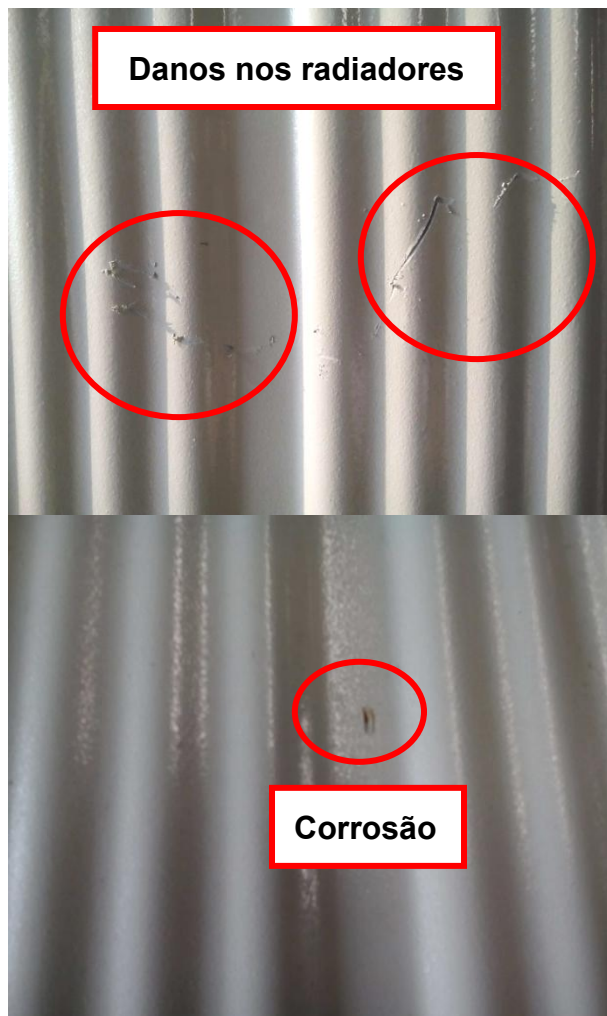
Figura 1 – Danos na cuba do transformador
