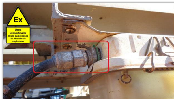
Figura 2 – Luminária do tipo “segurança aumentada”, com certificação Ex “e” encontrada em área classificada com prensa-cabo sem aperto, com ingresso de água para o interior do invólucro
