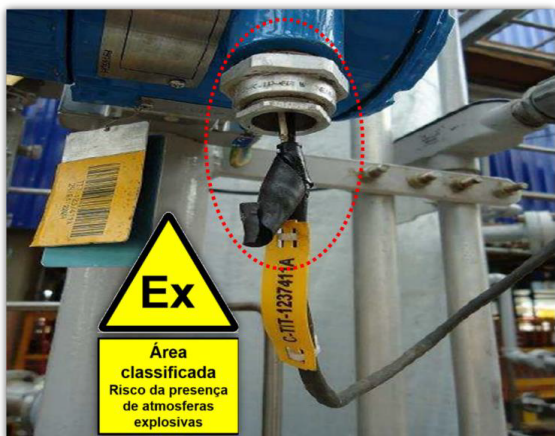
Figura 7 - Instrumento com invólucro metálico com certificação "à prova de explosão" encontrado instalado em área classificada com prensa-cabos Ex "d" que não aperta adequadamente o cabo
