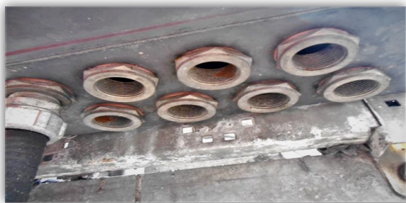
Figura 5 - Caixa de junção com certificação "segurança aumentada" (Ex "e") encontrada instalada em área classificada com entradas de cabos não utilizadas abertas, sem a instalação dos devidos bujões "Ex"
