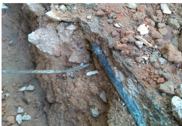
Figura 11: Detalhe do espaçamento entre o tubo metálico do gás e o cabo do SPDA.
