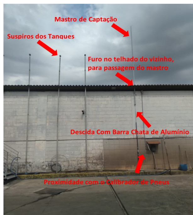
Figura 6 – Mastro de captação fixado na estrutura do vizinho
