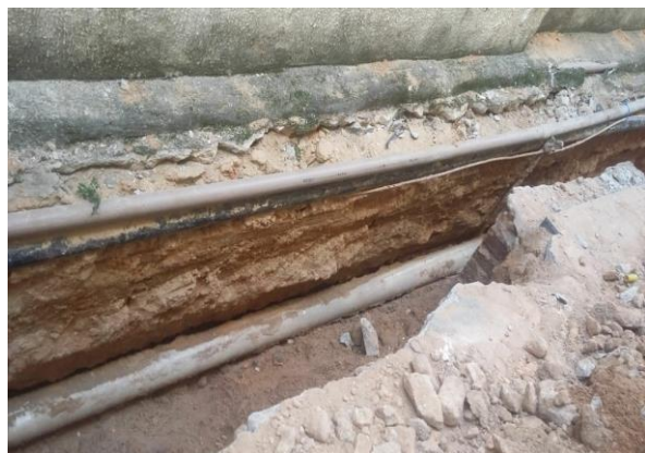
Figura 10: SDGC e a malha de terra do SPDA.
