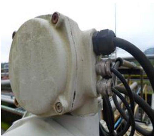
Figura 6 - Acionador elétrico de válvula de bloqueio motorizada, com invólucro metálico certificado "à prova de explosão", encontrado com sinal de dano ao invólucro devido à necessidade de utilização de talhadeira e marreta para abertura da tampa e instalação incorreta de prensa-cabo Ex "e" de material plástico
