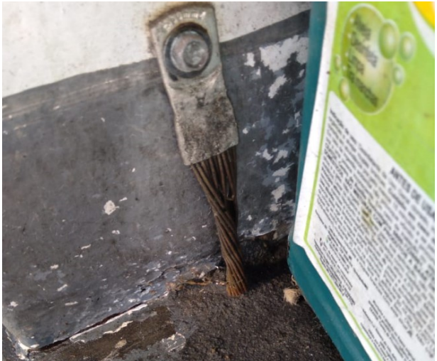
Figura 4 – Utilização de cabo de 19 fios não normatizado em subsistema de aterramento
