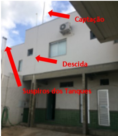
Figura 3 – Falhas nos Subsistemas de Captação e Descidas
