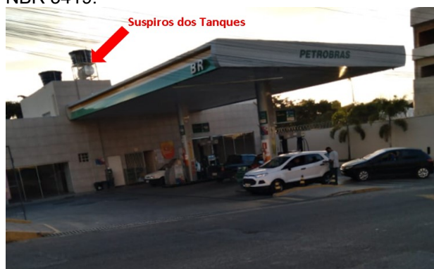
Figura 5 – Posto de combustível sem PDA instalado
