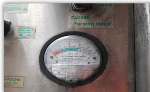
Figura 4 – Equipamento elétrico com invólucro pressurizado com certificação do tipo Ex “p” encontrado instalado em área classificada sem pressurização interna
