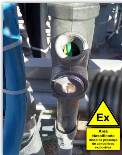
Figura 9 - Unidade seladora de eletroduto com certificação "à prova de explosão" encontrada instalada em área classificada sem a necessária selagem interna (vazia)
