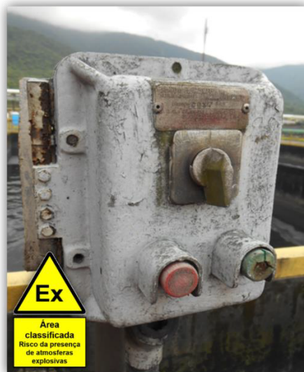
Figura 8 - Botoneira com invólucro metálico com certificação "à prova de explosão" encontrada instalada em área classificada com falta de parafusos de fixação da tampa
