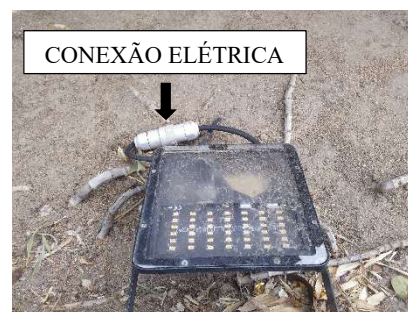
Figura 9 – Conexão elétrica para projetor instalado no solo. Fonte: Autores, 2023.
