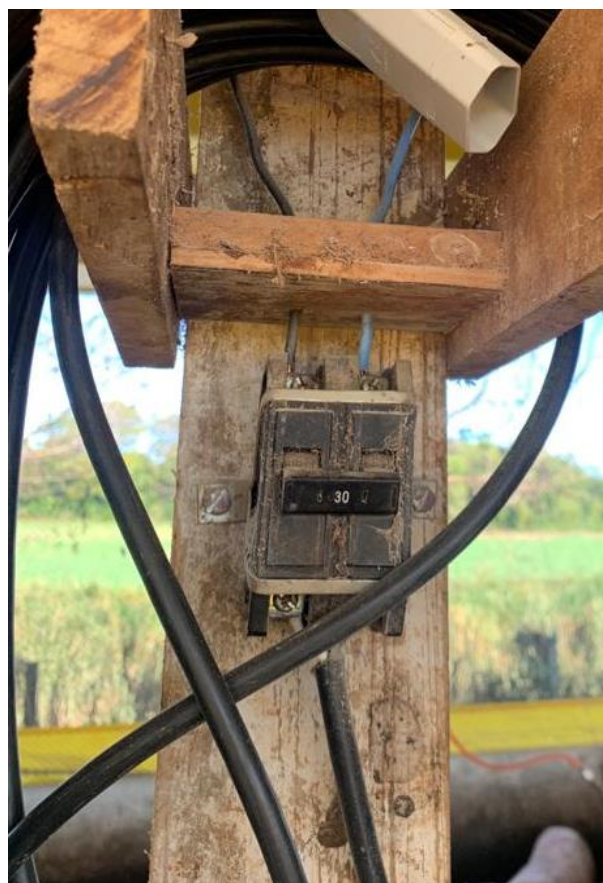
Figura 4 – Disjuntor instalado em poste de madeira
