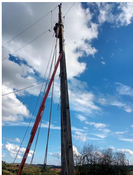
Figura 17: Poste aterrado com dois selas neutro, um do aterramento temporário e outro para a equipotencialização do eletricista
