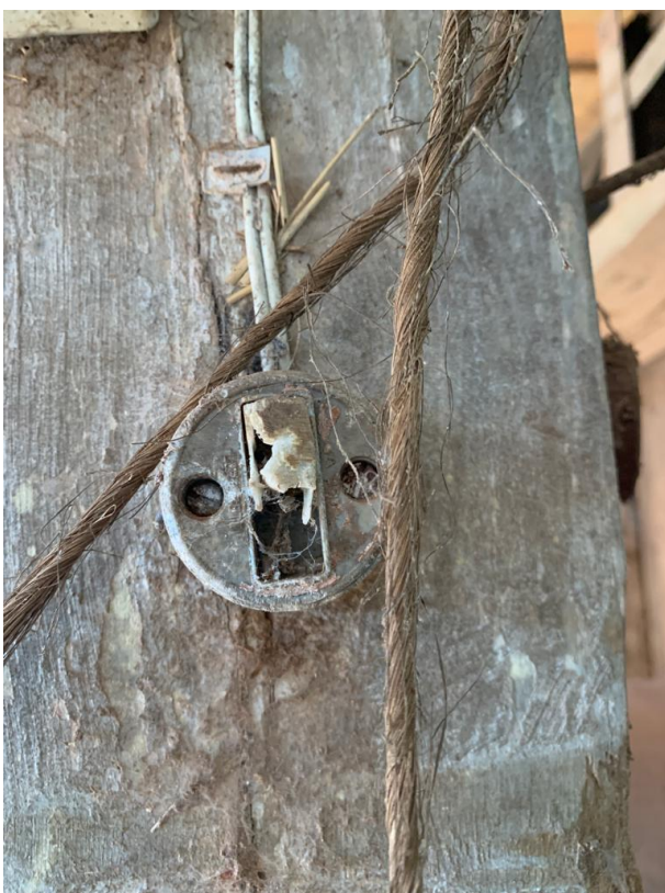
Figura 2 – Interruptor danificado
