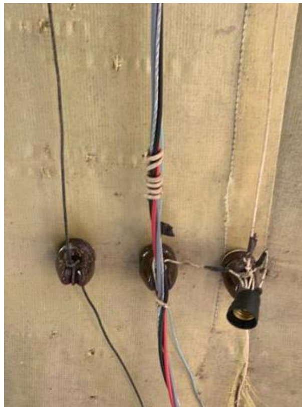
Figura 3 – Condutor multiplex utilizado em área interna, com emenda direta ao condutor de cobre
