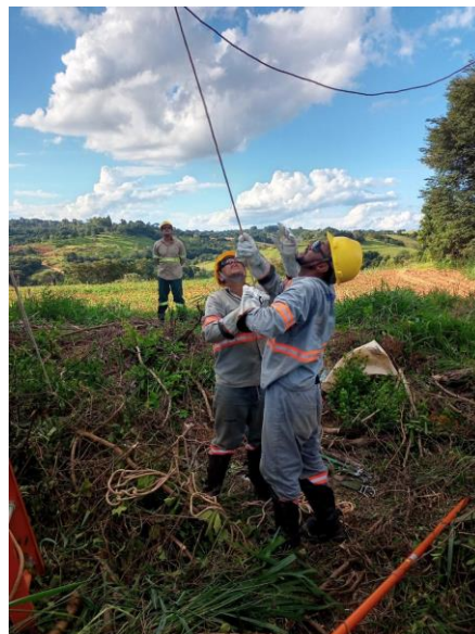
Figura 20: Eletricistas elevando o cabo rompido
