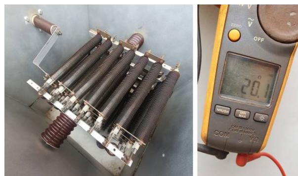
Figura 7 – Resistor de aterramento do neutro (400 A)
