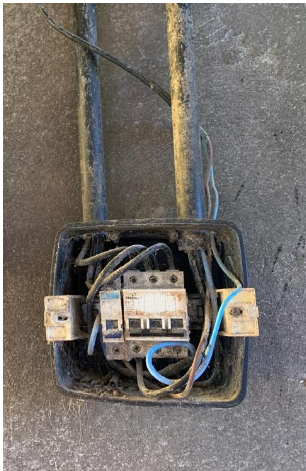
Figura 5 – Quadro de distribuição sem tampa
