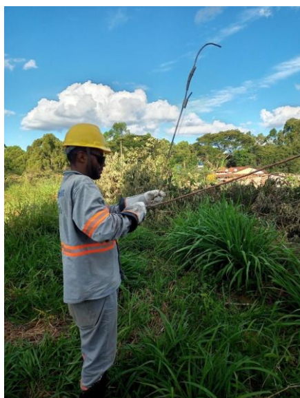
Figura 18: Eletricista instalando Grampo do segundo sela no neutro rompido, utilizando luvas isolantes.
