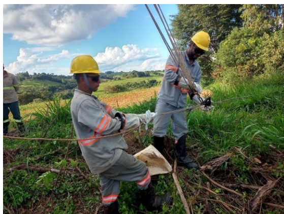
Figura 19: Eletricistas instalando o moitão para elevar cabo rompido, utilizando luvas isolantes.
