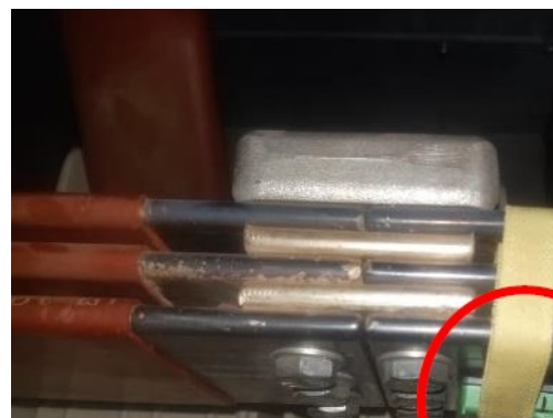
Fig. 02 – Exemplo de uma das tecnologias empregadas no monitoramento de temperatura de barramentos em Painéis de Média Tensão.
