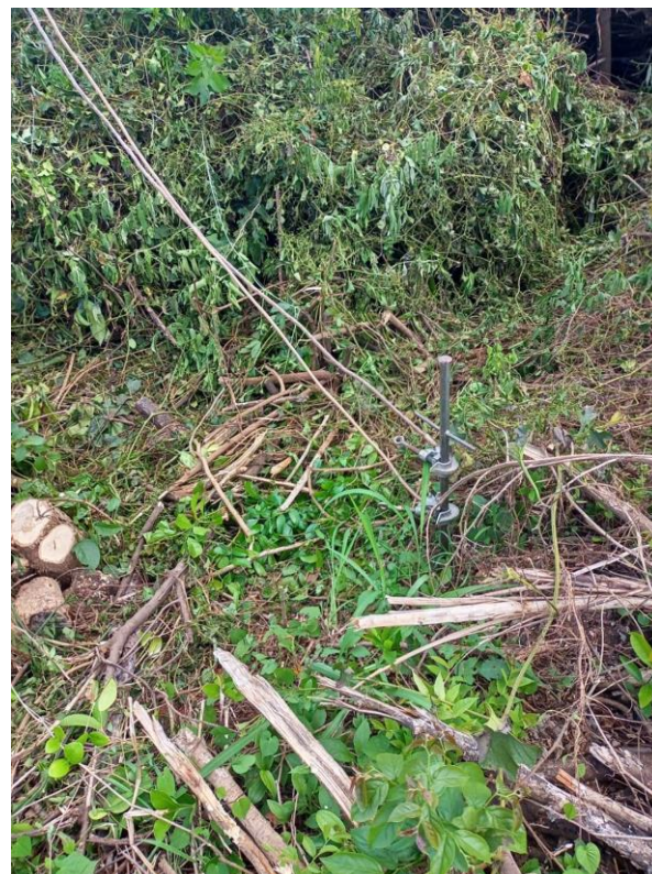
Figura 16: Haste de aterramento com os dois grampos dos selas neutro instalados no poste. Fonte: dos Autores
