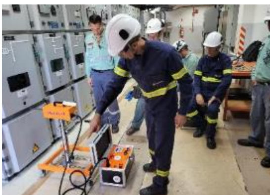
Fig. 03 – Sistema portátil de inserção e extração de disjuntores e contatores.
