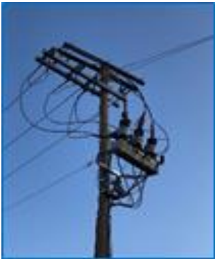
Figura 6 – Religador instalado no poste.
