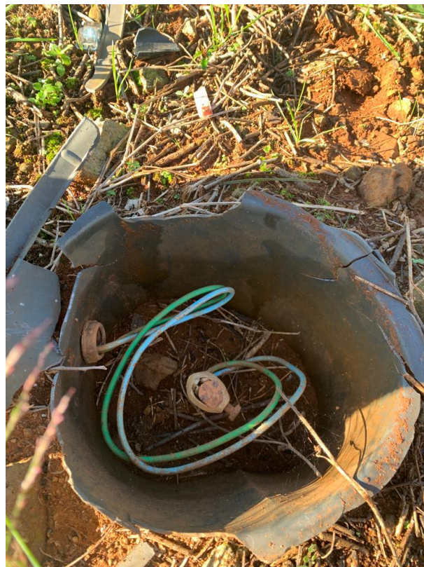
Figura 6 – Aterramento da alimentação, com condutor neutro e proteção
