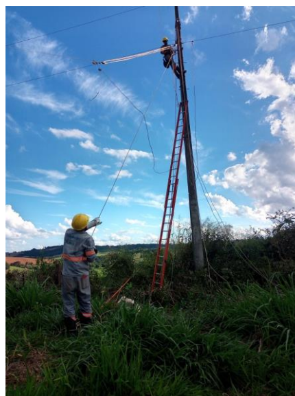
Figura 21: Eletricista utilizando luvas de vaqueta na estrutura recebendo o cabo, estando equipotencializado.
