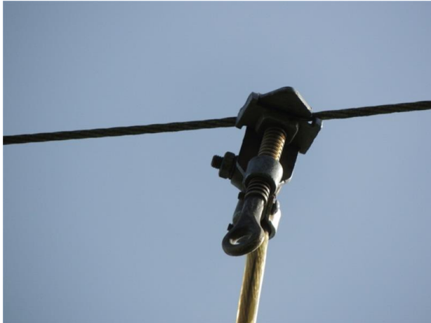
Figura 2: Grampo mal posicionado Fonte: dos Autores
